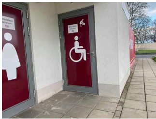
WC neben Hallenschau 1 – Tür zur Toilette
