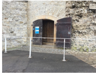
Eingangsbereich am Aussichtsturm
