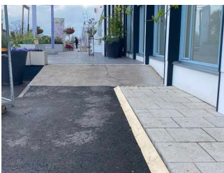
Rampe zur Halle 1
