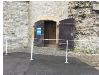
Eingangsbereich am Aussichtsturm
