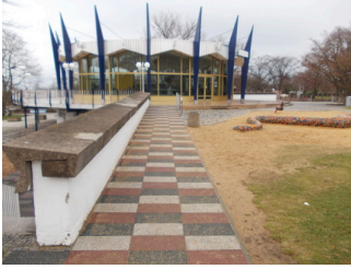
Restaurant RUNDBAU mit Rampe
