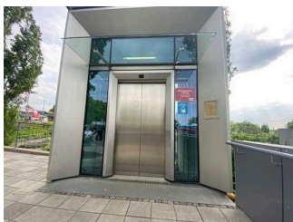
Aufzug zum Eingang
