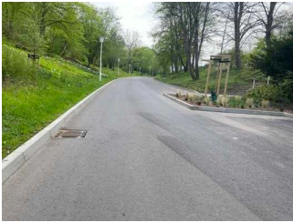
Weg vom Eingang Gothaer Platz zum Hauptweg beim Danakil-Haus
