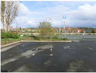
Parkplätze am Haupteingang mit unterschiedlichen Breiten
