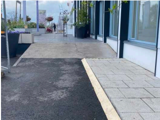
Rampe zur Halle 1
