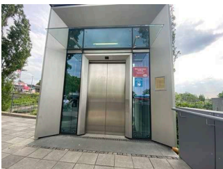
Aufzug zum Eingang
