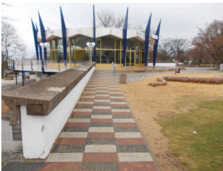
Restaurant RUNDBAU mit Rampe
