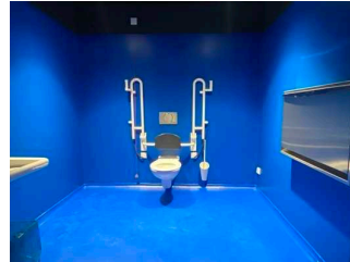
DANAKIL mit WC im Untergeschoss
