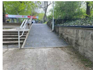
Weg zum Eingang Gothaer Platz – Rampe 2 (20% Steigung)
