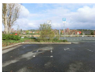
Parkplätze am Haupteingang mit unterschiedlichen Breiten
