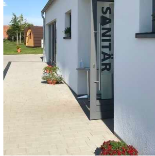
WC, Dusche, Waschraum
