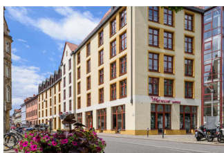
Außenansicht des Mercure Hotels Erfurt Altstadt
