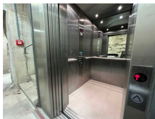
Blick in den Fahrstuhl
