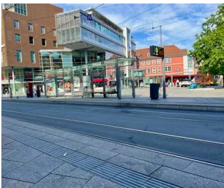
Anger Straßenbahnhaltestelle – Wartehalle und Blindenleitsystem
