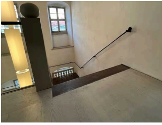
Historische Treppe – 2.OG
