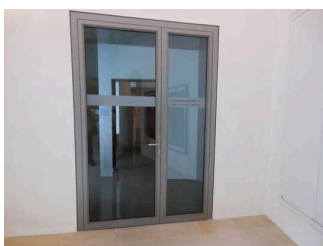
Tür Junkersandzimmer 1.Etage
