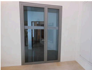
Tür Junkersandzimmer 1.Etage
