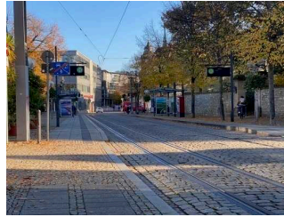
Straßenbahnhaltestelle Linie 2 THEATERPLATZ
