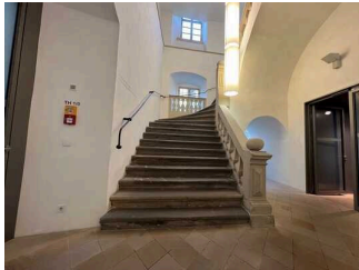
Historische Treppe mit Steinstufen – Blick vom EG
