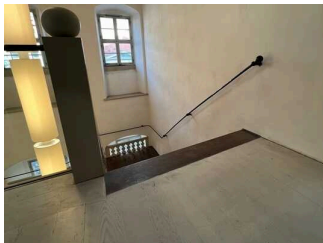
Historische Treppe – 2.OG
