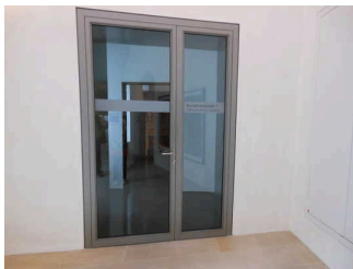
Tür Junkersandzimmer 1.Etage
