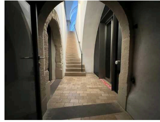
Treppe zum WC – Blick vom Untergeschoss
