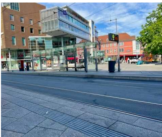
Anger Straßenbahnhaltestelle – Wartehalle und Blindenleitsystem
