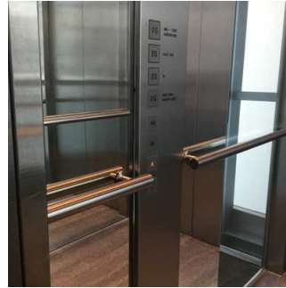
Bedientableau im Aufzug
