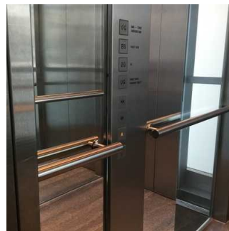
Bedientableau im Aufzug
